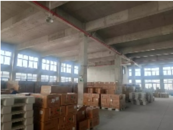
仓储实景照片
